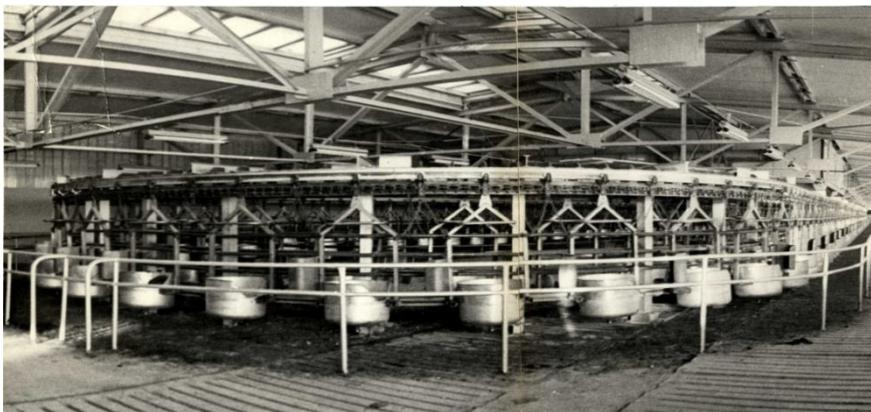
*Рис. 1. Общий вид кормового конвейера с косым расположением животных, п. Кудьма*
